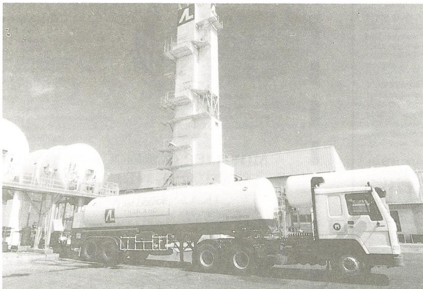
Depuis 1992, une nouvelle usine à Nongkae, Saraburi, produisant 250 tonnes par jour d'oxygène, azote, hydrogène et argon.
