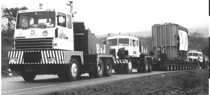
L'ascension du transformateur s'effectue à l'aide de trois camions
