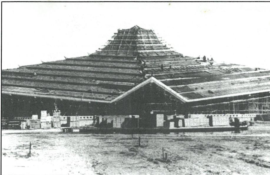
L'Inter-Continental lors de sa construction en 1966
