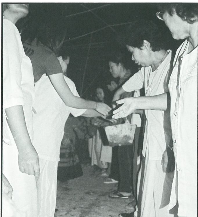
Les participants forment une chaîne pour transporter les seaux de ciment de la bétonneuse à la statue en construction.
