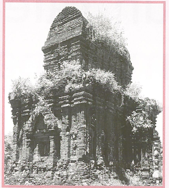
Edifice cham dit « B5 » (sanctuaire de Mỹ Sơn)
